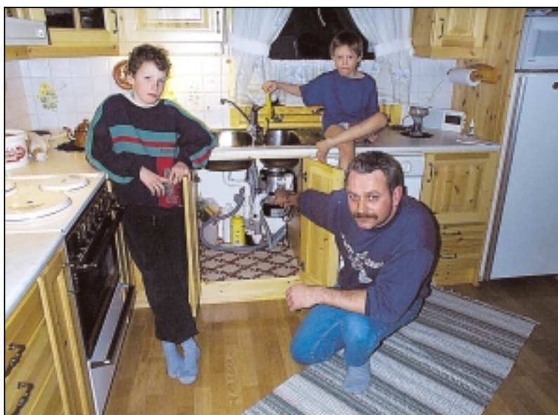
Bjørn Hovde viser frem den elektriske kverna for matavfall som er montert i vasken. Matavfallet går sammen med avløpsvannet til kloakkrensianlegget.
